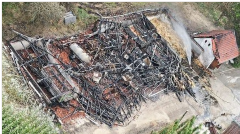
Luftblick: Die Halle brannte komplett nieder.
